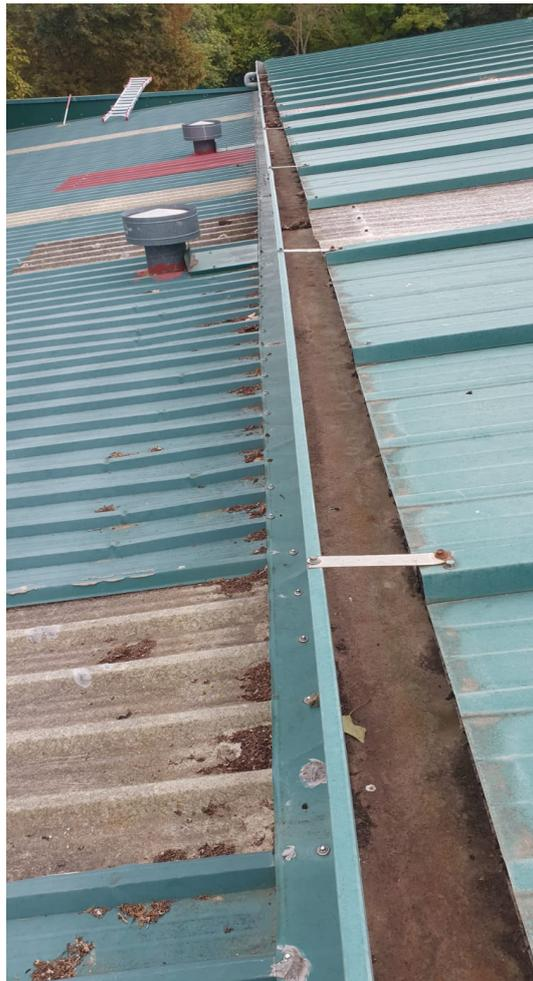
Los trabajos a realizar consisten en el desmontaje de 55 m<sup>2</sup> de lucernario existente realizado por medios manuales con transporte de material a vertedero autorizado.
