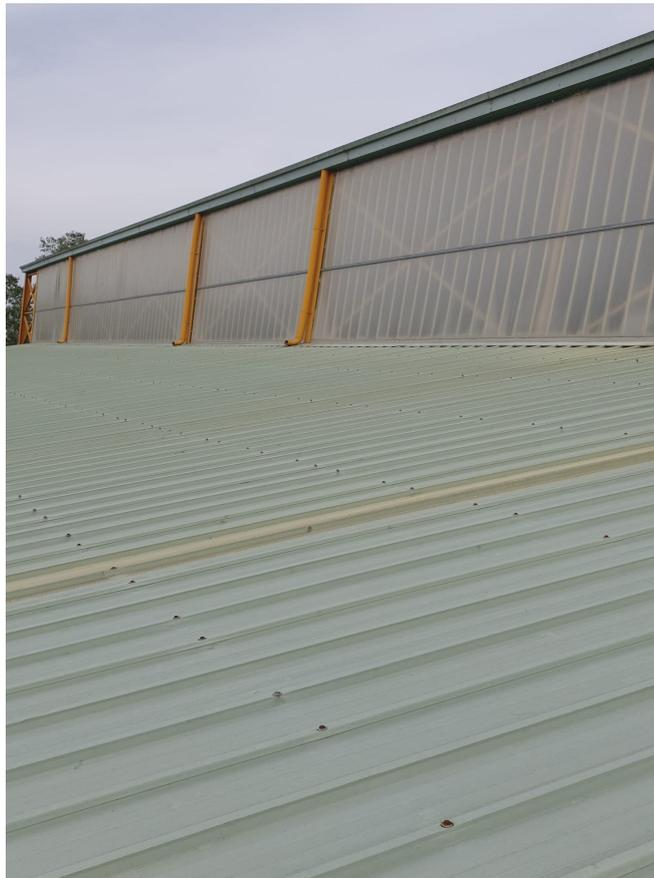
Los trabajos consistirían en el desmontaje de 32 m<sup>2</sup> de placas de poliéster simple de lucernarios existentes en fachada y retirada a vertedero autorizado.
